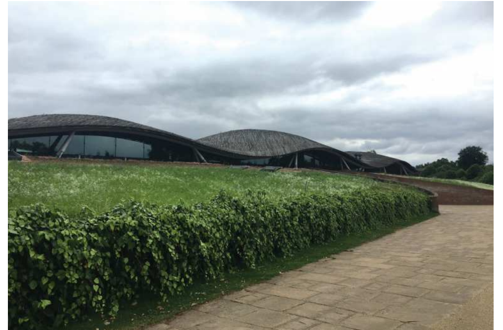
여러 곡선의 형태로 이루어진 건물은 마치 물결을 연상케 하며, 독특하면서도 현대적인 디자인을 갖추고 있다.
